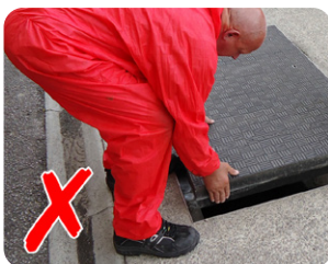
Technique dangereuse sans la clé de levage Fibrelite
