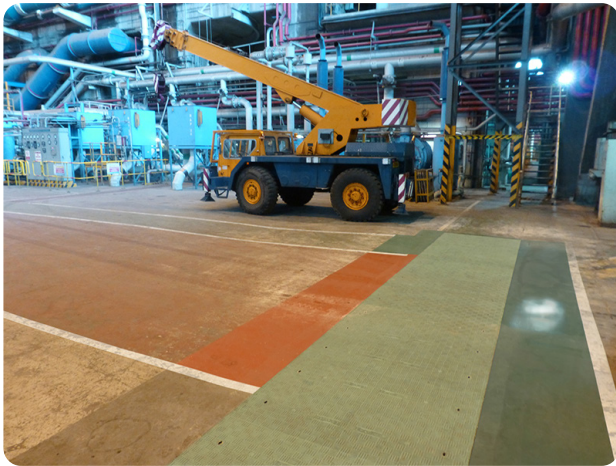
Szeroka rozpiętość. Pokrywy do kanałów Fibrelite dostępne w długościach do 1600 mm w klasie obciążenia D400 (40 ton).
