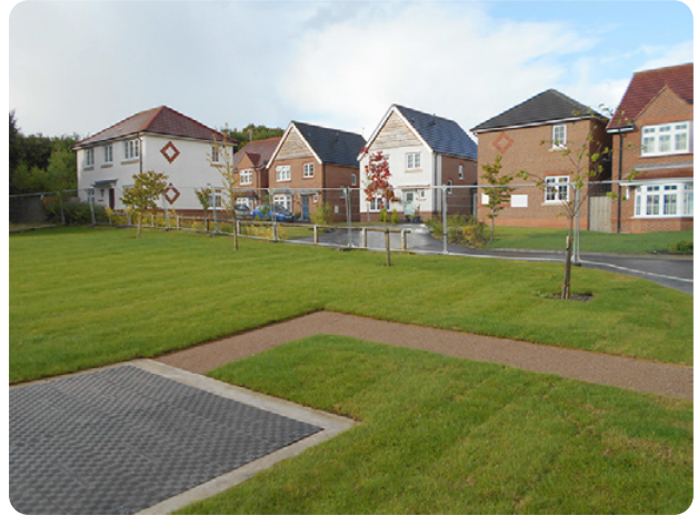
Das Erscheinungsbild der Abdeckungen fügt sich angenehm in die Umgebung ein
