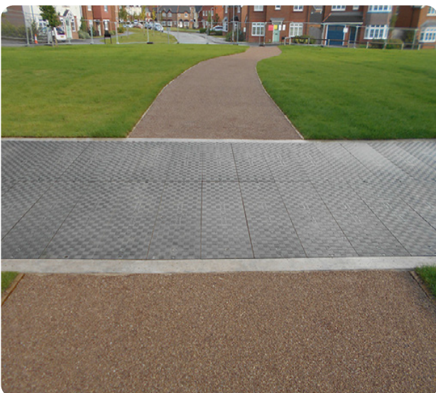
In den Faserverbundabdeckungen sind werkseitig spezielle rutschhemmende Materialien eingearbeitet
