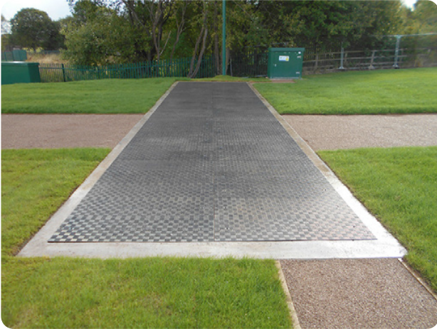
Eingepasste Faserverbundabdeckungen in Belastungsklasse B ( 12,5 to)
