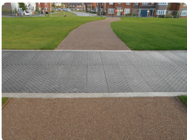
Specjalna struktura antypoślizgowa powierzchni pokryw Fibrelite
