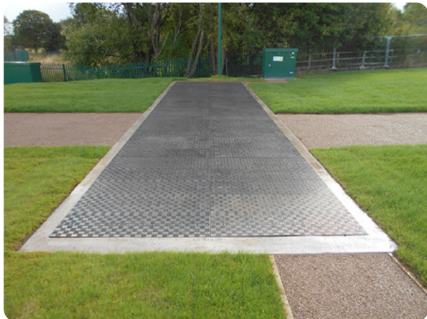
Zainstalowane pokrywy Fibrelite w klasie obciążenia B125 (12,5 tony)
