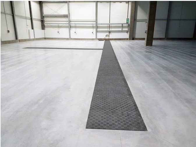
Fibrelite monterade D400-lock vid en polsk tillverkningsanläggning
