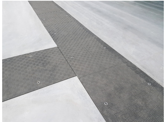
Fibrelite och Corrimex monterade en T-koppling som en del av projektet
