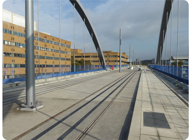
Las tapas Fibrelite tuvieron que fabricarse ajustándose a las arquetas preinstaladas.
