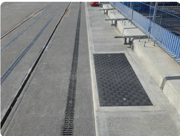
Panel de cubrición a medida para la acera de la vía
