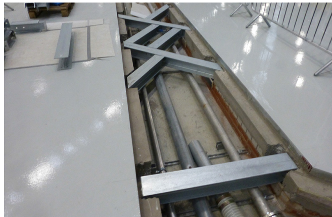
I chiusini Fibrelite necessitavano di essere realizzati per adattarsi ad alcuni supporti in acciaio già installati
