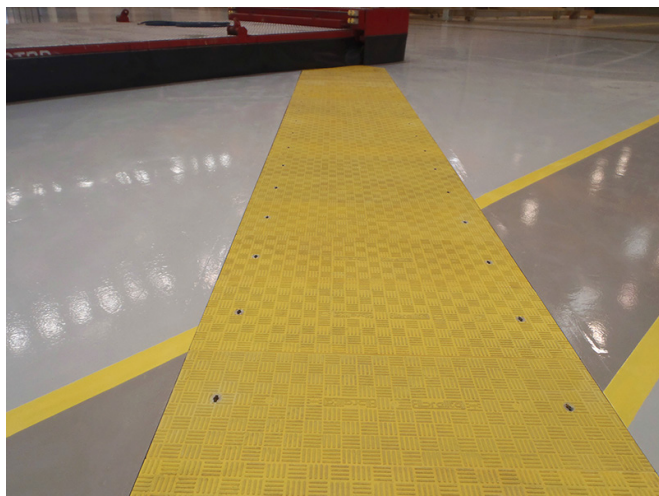
I chiusini modulari prodotti da Fibrelite in classe C250 per copertura cunicoli
