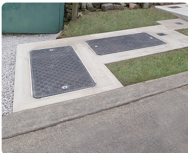
25 ton obciążenia testowane
