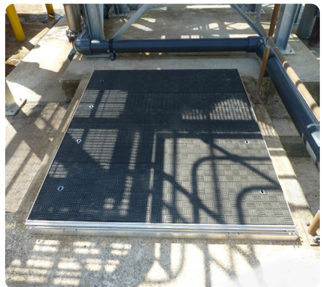
Leichte Flächenabdeckungen aus Faserverbund in Belastungsklasse B (12,5 to)
