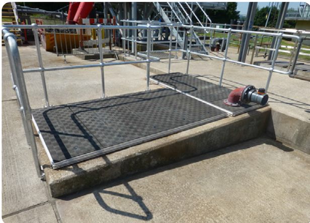
Ein Entlüftungrohr kann problemlos in einer Faserverbundabdeckung integriert werden
