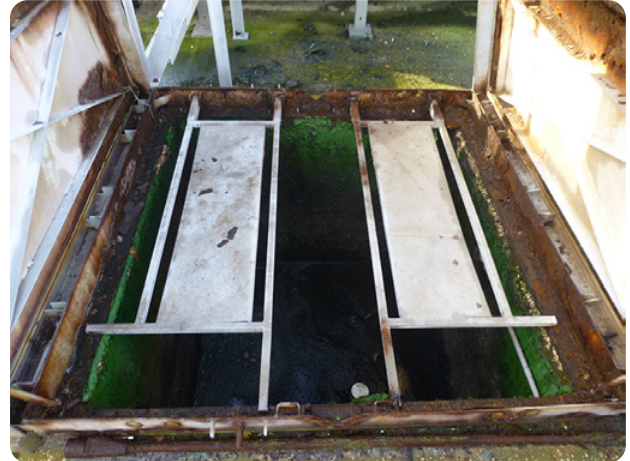
Die alten Stahlabdeckungen wurden durch leichte Faserverbundabdeckungen ersetzt
