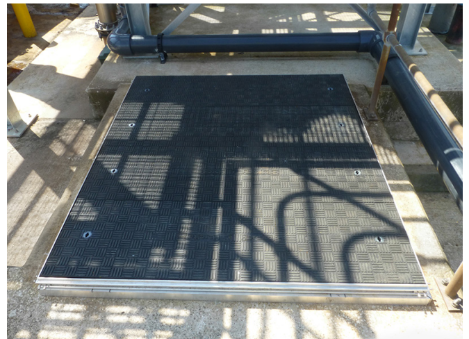
Il chiusino A15 di Fibrelite, estremamente leggero e facile da movimentare
