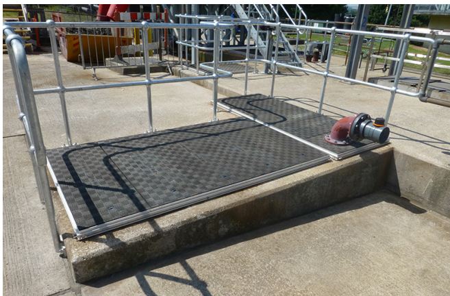
Una specifica tubazione per la ventilazione può essere incorporata nel chiusino Fibrelite
