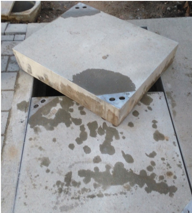
Oryginalne pokrywy stalowo-betonowe o głębokości 17cm
